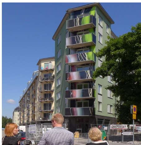
Konstinstallation til Familjebostäder
